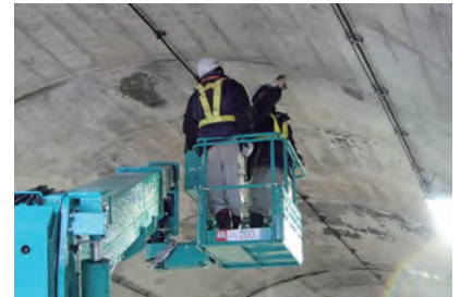
近接目視による点検
