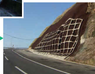
道路の法面対策
