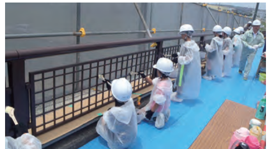
児童による橋梁高欄の塗装体験
