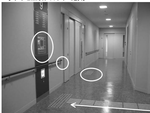
手すりと点状ブロックで誘導
