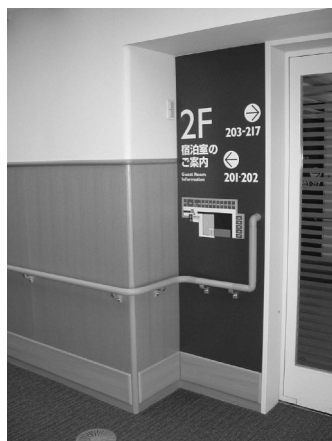
大きく曲がる手すり
