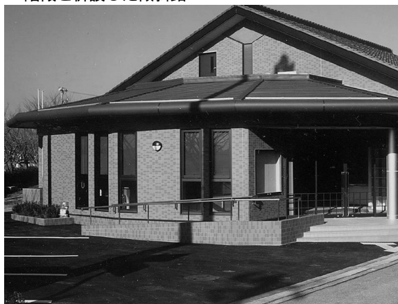
階段と併設した傾斜路
