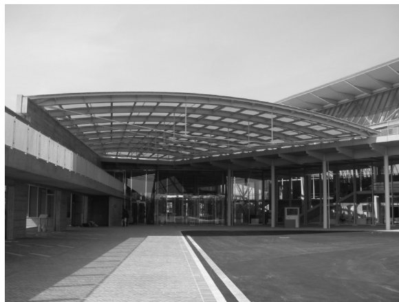
駐車場から出入口まで連続した軒と屋根
