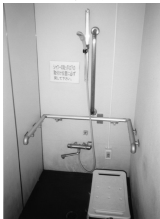
シャワー室内の手すり
