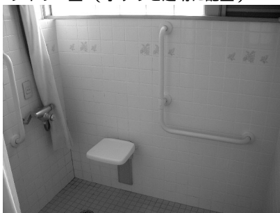
シャワー室（手すりを適切に配置）
