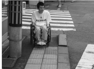
電柱でさらに狭くなった歩道
