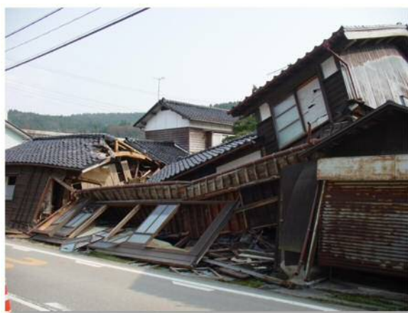
※写真：倒壊した住宅（平成 19 年能登半島地震）
