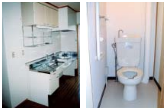
住戸改修（キッチン、トイレ）
