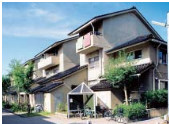
建替え後の 36・37 号棟 （昭和 58 年度）
