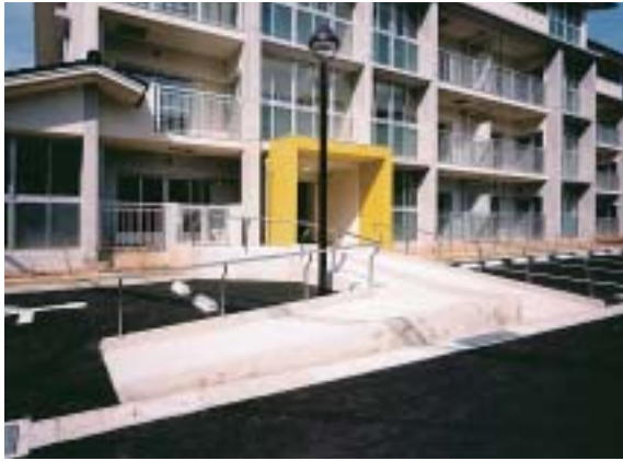
手すりを設置したスロープ
