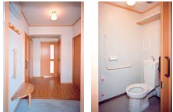
(左) 手すりやベンチを設置した玄関
