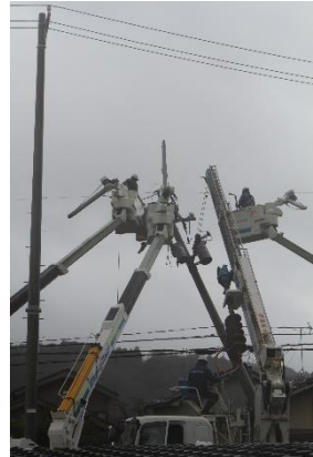
商用電源の復旧 (北陸電力送配電)
