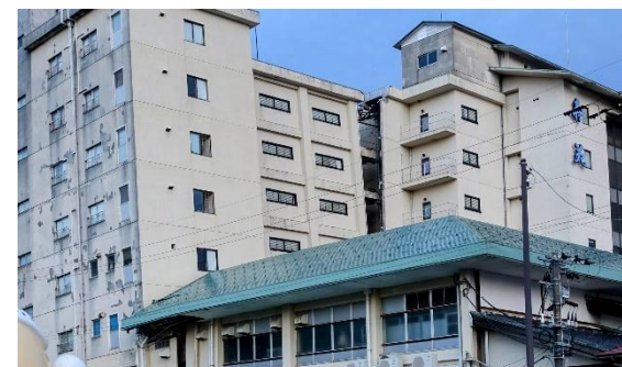
建物損壊（和倉温泉（七尾市））
