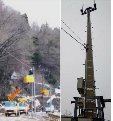
基地局の修理 (NTTドコモ)
