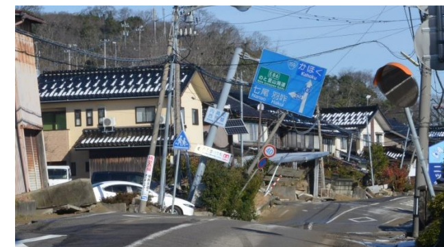
液状化（内灘町西荒屋地内）
