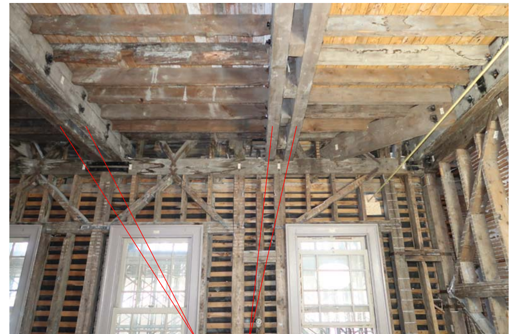
挟み梁 (二階床梁)
