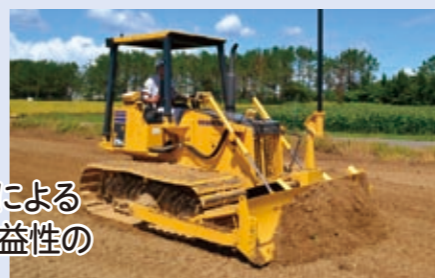
ICTブルドーザの活用
