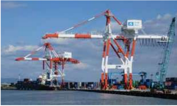
御供田国際コンテナターミナル（金沢港）
