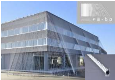
建築構造物の耐震補強材
