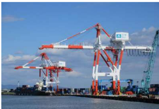
御供田国際コンテナターミナル（金沢港）
