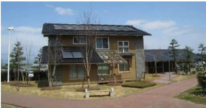
いしかわエコハウスの外観 （石川県産業振興ゾーン）
