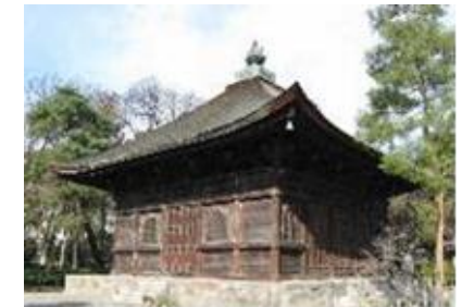
炭素繊維素材を善光寺経蔵 (重要文化財)などの耐震補 強材に使用 (小松マテーレ(株))
