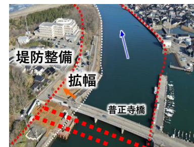
河川改修(犀川)
