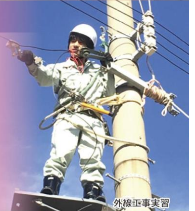
外線工事実習
