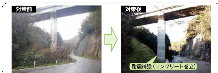
橋梁耐震補強 [(主) 志賀富来線]
