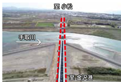
加賀海浜産業道路（手取川架橋区間）
