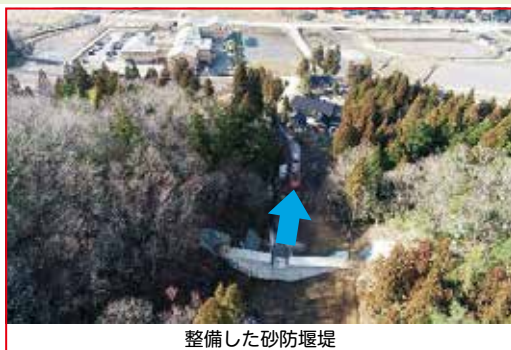
整備した砂防堰堤
