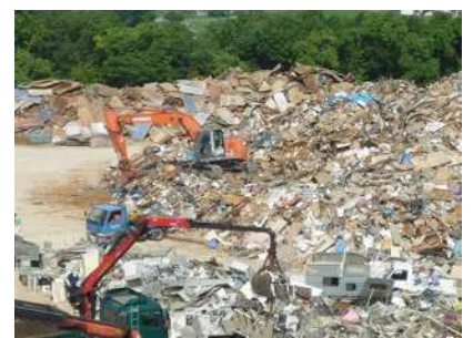
災害廃棄物の仮置場の管理
