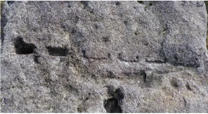
石垣（未製品）に残る矢穴 矢穴を掘る作業が中断・ 停止した状態 【いもり堀園地（キゴ山石）】
