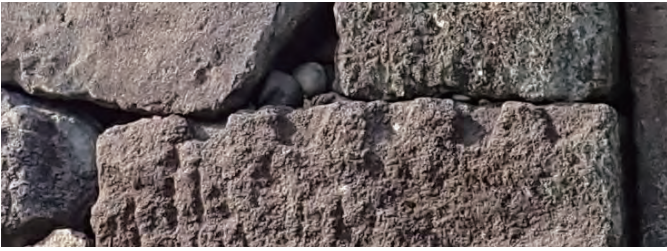
石垣に残る矢穴 矢割が完了し、矢穴は分割された状態 【尾坂門】
