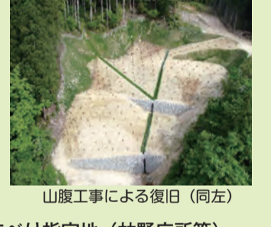
山腹工事による復旧 (同左)
