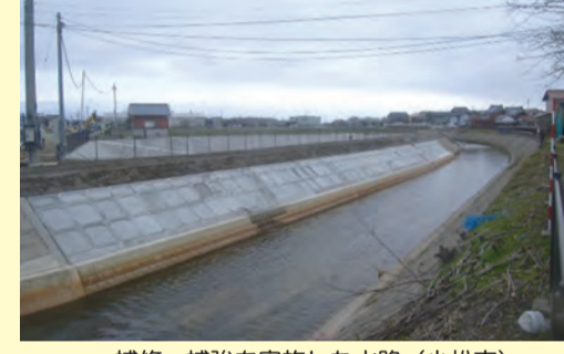
補修・補強を実施した水路 (小松市)
