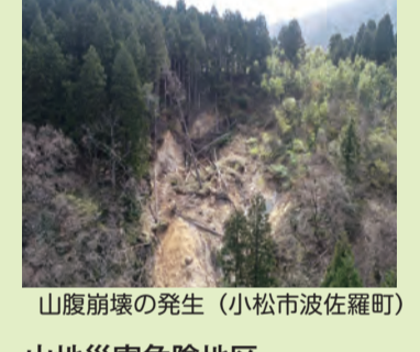
山腹崩壊の発生 (小松市波佐羅町)
