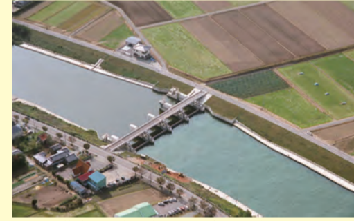
柴山湯水位を管理する新川門止水門
