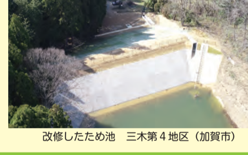
改修したため池 三木第4地区 (加賀市)
