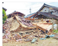
地震による被害
