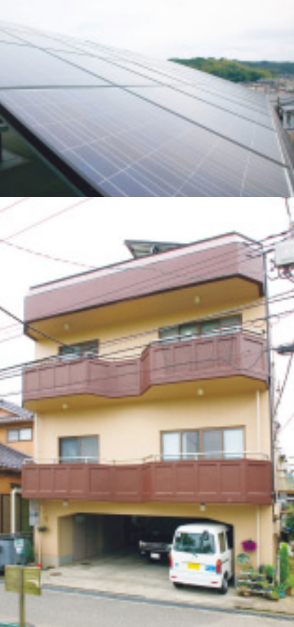
屋上に太陽光発電システムを設置
