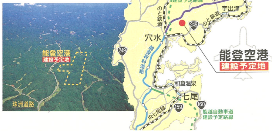
点線内が能登空港建設予定地
