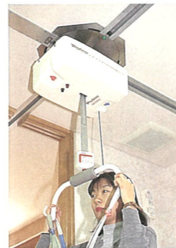
和室、寝室、トイレ、浴室を結ぶ天井走行リフト
