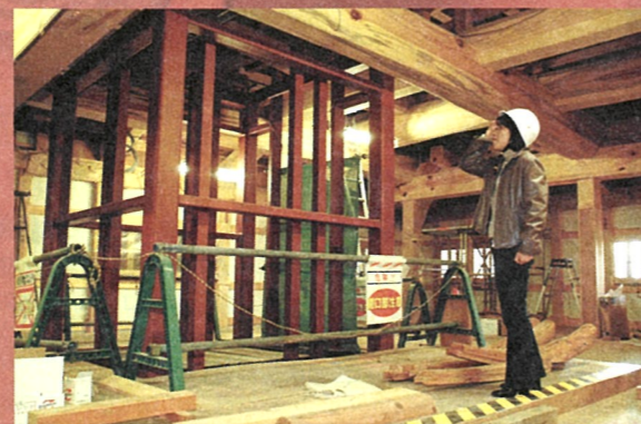
続櫓に設置されるエレベーター。場所は、当時、荷揚げ場に使われた穴があったところで、平成金沢城ではガラス張りのエレベーターに変身します。
