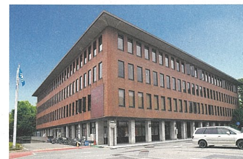
オペレーティング・ユニットの活動拠点となる県広坂庁舎
