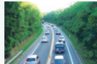
のと里山海道の(柳田IC~上棚矢駄IC)の渋滞状況(平成27年度より4車線化に着手)
