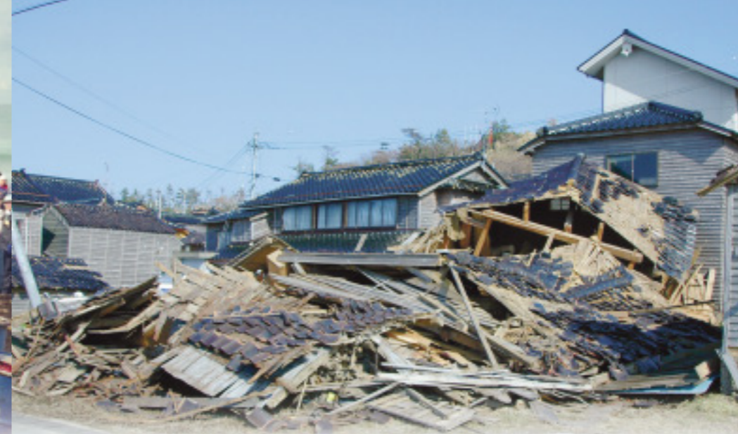
輪島市を中心に住宅被害が拡大 (2007年3月/輪島市門前町)
