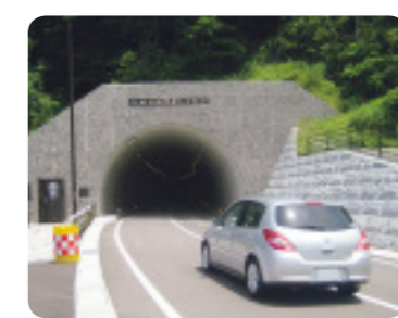
復旧工事で八世乃洞門新トンネル(輪島市・珠洲市間)を建設
