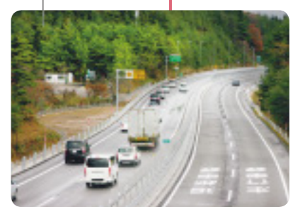
のと里山海道では復旧の際に整備した迂回路をゆずりレーンとして活用(穴水町)
