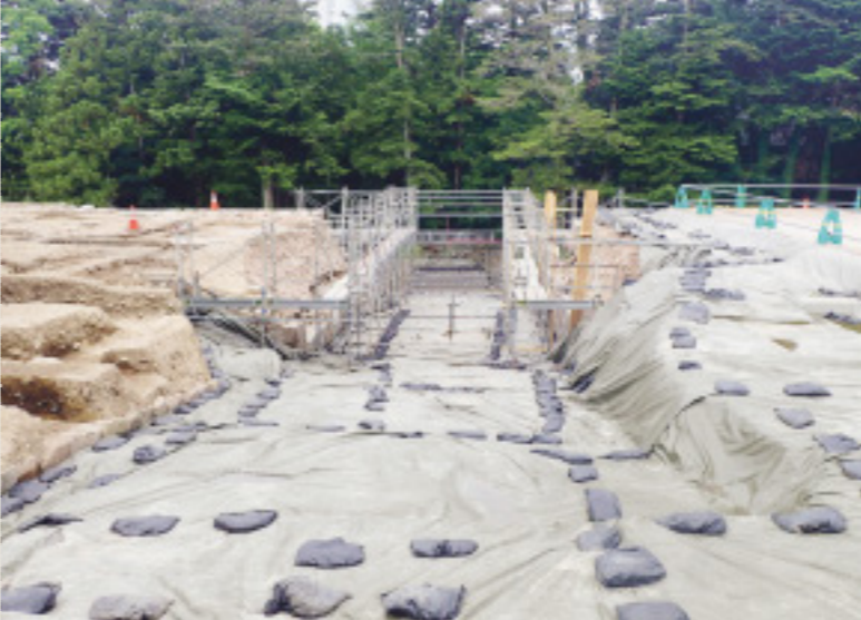
基礎となる石垣の復元を行う鼠多門の整備現場
