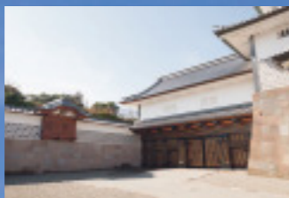
2015年に復元整備した橋爪門
