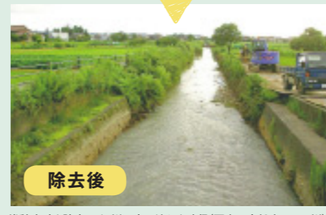
堆積土砂を除去し、河川の水の流れを確保(写真は小松市の八丁川)
