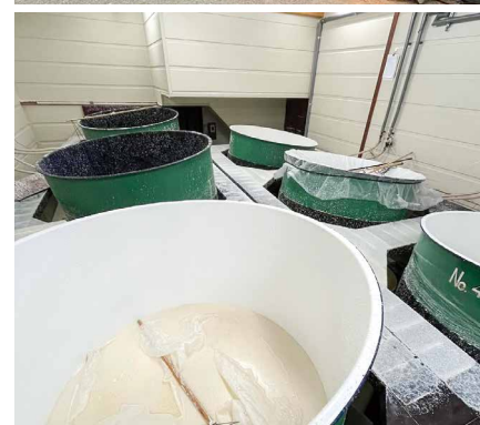
震災直後の様子。蔵自体は倒壊を免れたものの、タンクや設備に甚大な被害を受けた。
