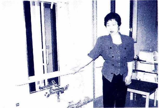
脱衣場と浴室の水平手すり
