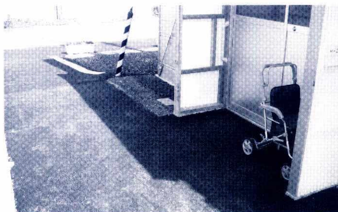
玄関入口の段差解消
