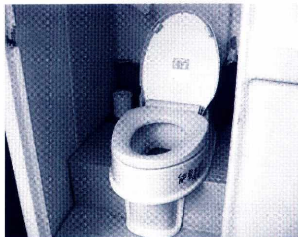
仮設トイレの洋式化
