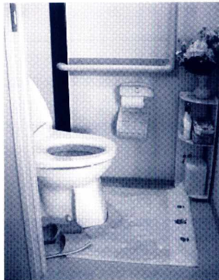
トイレの手すり設置
