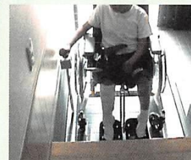
玄関に段差解消機と引き戸を設置したことで、電動車いすで外出が可能になりました。
