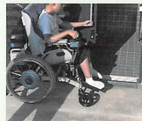
玄関に段差解消機と引き戸を設置したことで、電動車いすで外出が可能になりました。
