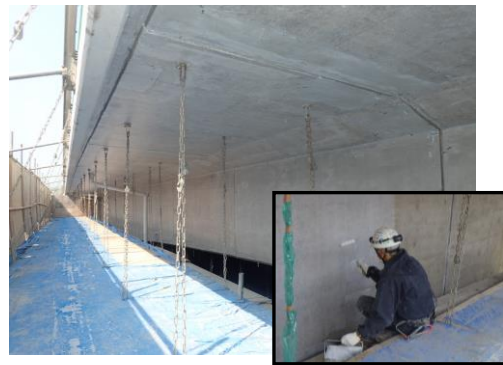
主要地方道 金沢田鶴浜線【内灘海浜橋】・・・断面修復 表面保護
