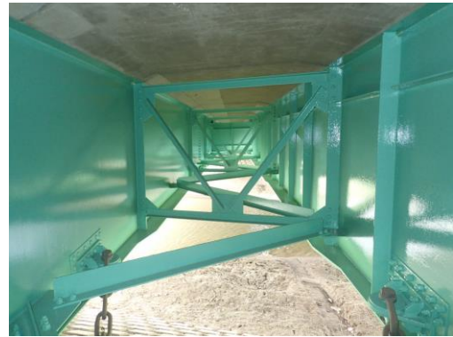
一般県道 向粟崎安江町線【田中橋】・・・塗装塗り替え
