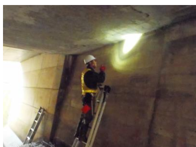
梯子による近接目視点検
