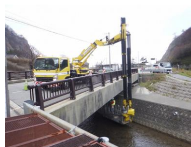
橋梁点検車による近接目視点検
