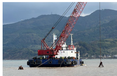
起重機船（弘武）による緊急浚渫状況
