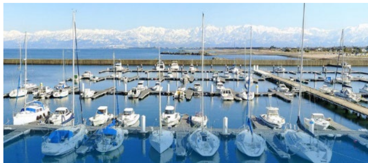
伏木富山港(ボートパーク事例)
