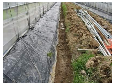
ハウス周辺の排水溝
