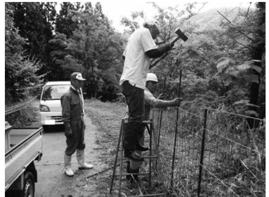
獣害防止柵の設置
