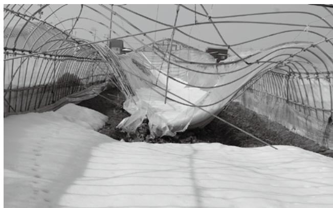
雪害によるビニールハウス倒壊の様子
