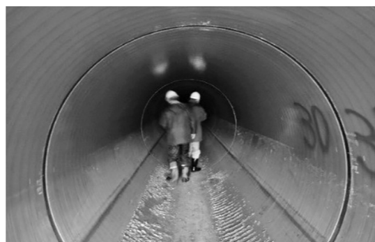
導水管路内部の様子
