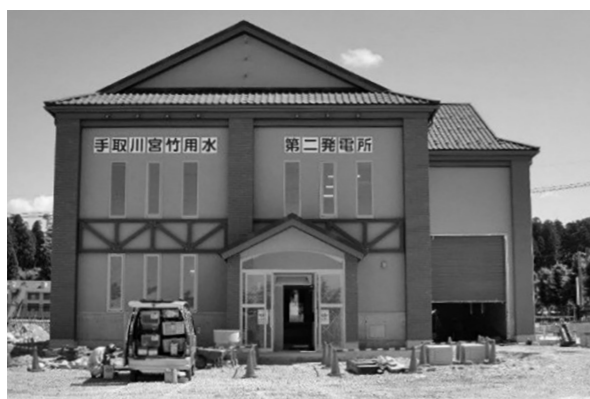
整備された手取川宮竹用水第二発電所上屋
