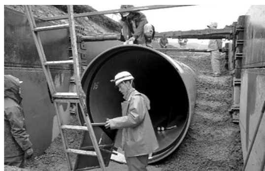
施工中の導水管路
