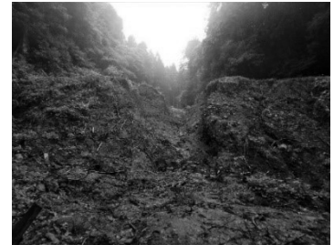
ため池廃止事例 ～七尾市中島町～
