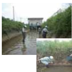
農業用水路の点検・診断状況
