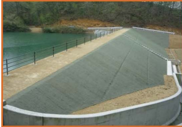
事業により改修されたため池
