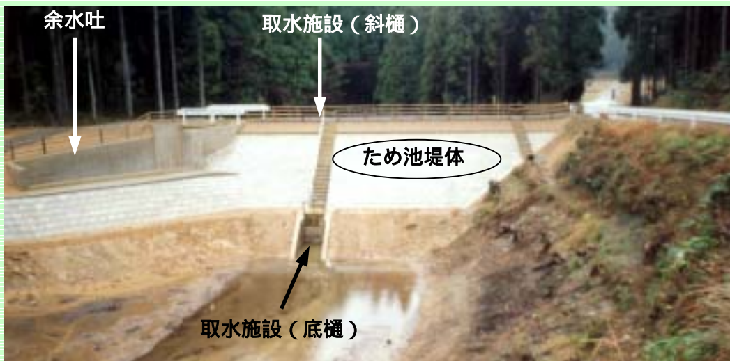
整備したため池
