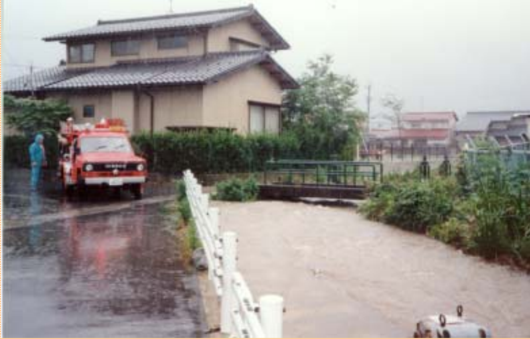
整備前の排水路
