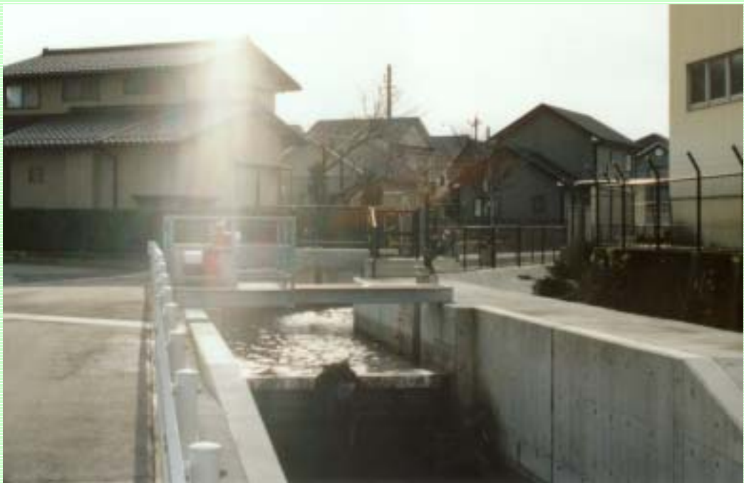
整備した排水路
