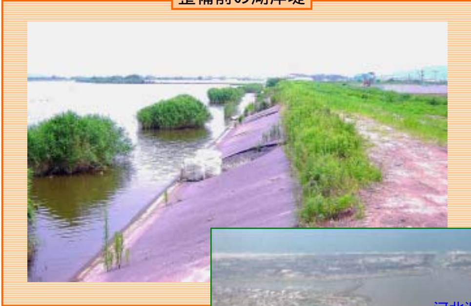
整備前の湖岸堤
