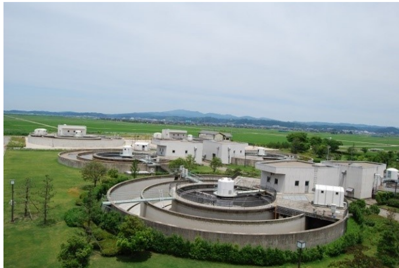
津幡町下水道浄化センター
