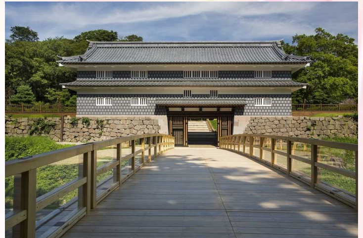
令和2年7月に金沢城に復元された 鼠多門(ねずみたもん)、鼠多門橋(ねずみたもんばし) (写真提供：金沢市)
