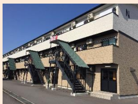
新設した外国人専用の寮（外観）
