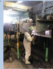
溶接作業の様子
