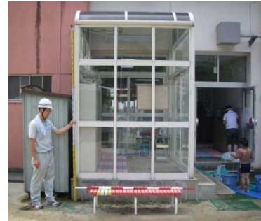
土砂流入経路を現地調査
