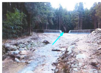
中能登町藤井地内 (堆積土砂除去)
